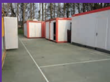
Les bâtiments temporaires, installés à proximité du stade.
